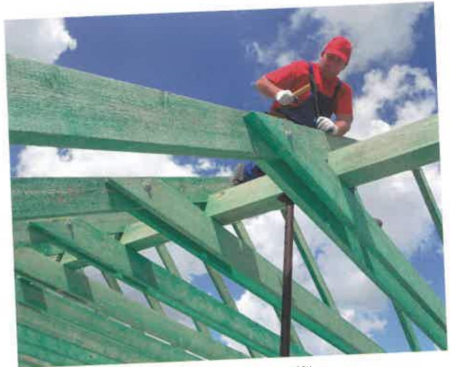
Střešní žezivo impregnované Bochemitem získá časově neomezenou ochranu proti napadení dřevokaznými škůdci.
