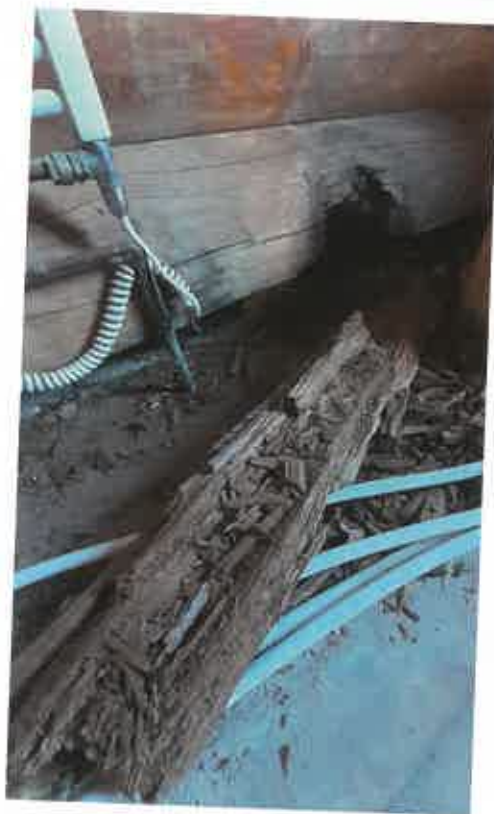
Podcenění impregnace: Náročná rekonstrukce srubu po několikaletém pozvolném protékání odpadu
